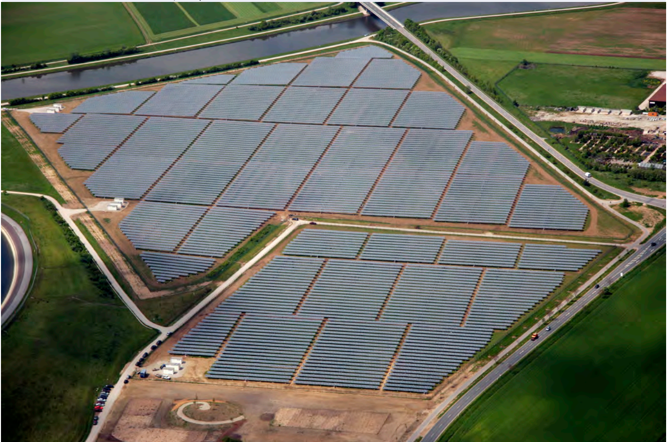
Central fotovoltaica de Brinches, Serpa.
