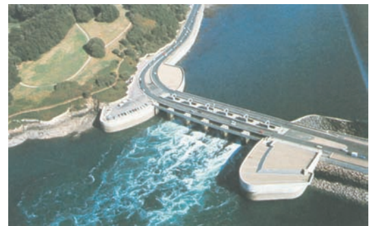
Dique da central de marés no estuário do rio Rance, em França: o desnível entre a maré alta e a maré baixa chega a atingir cerca de 8 m.
