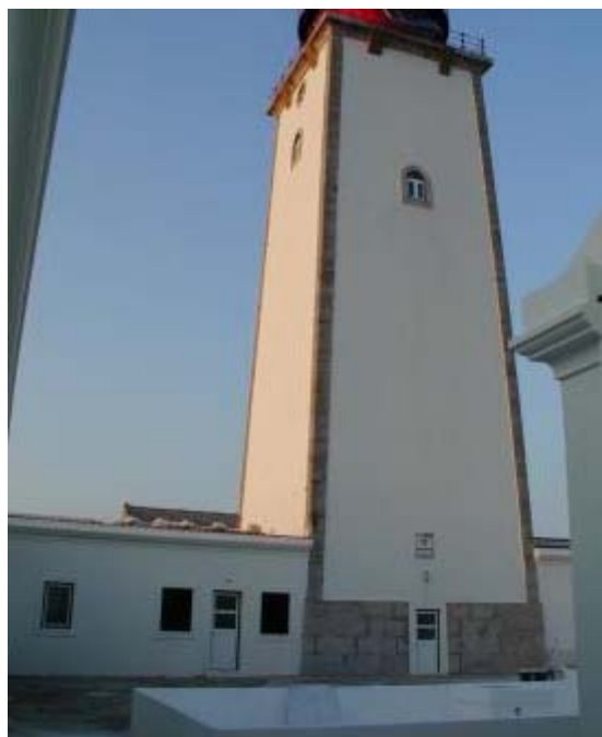
Fig. 44 - Com cerca de 29m de altura, num dia de boas condições atmosféricas a sua luz é visível numa área até cerca de 50 km.
