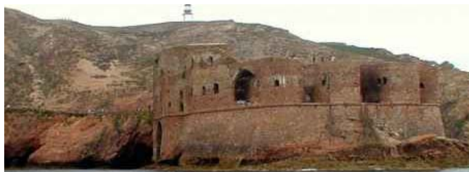
Fig. 16 - Vista do forte e do farol da ilha.
