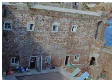
Fig. 38 - Vista do terraço dos quartos.
