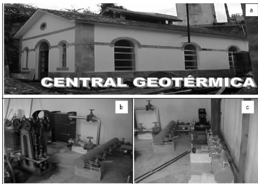
Imagem: Central geotérmica de S. Pedro do Sul, a) Aspecto exterior, b) Permutador b e c) Colectores
