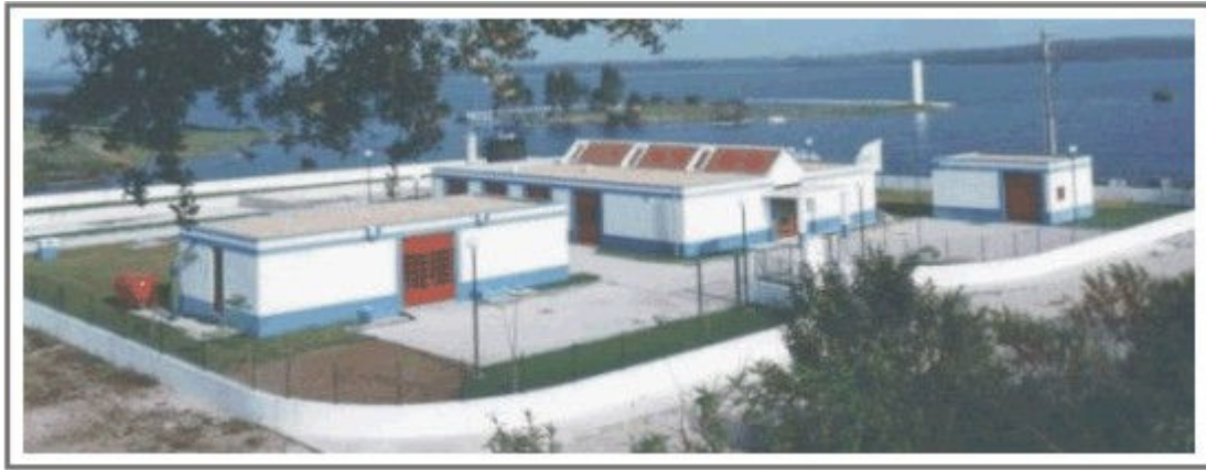
Figura 17. Estação de Tratamento de Águas da Barragem do Alvito (AMCAL).
