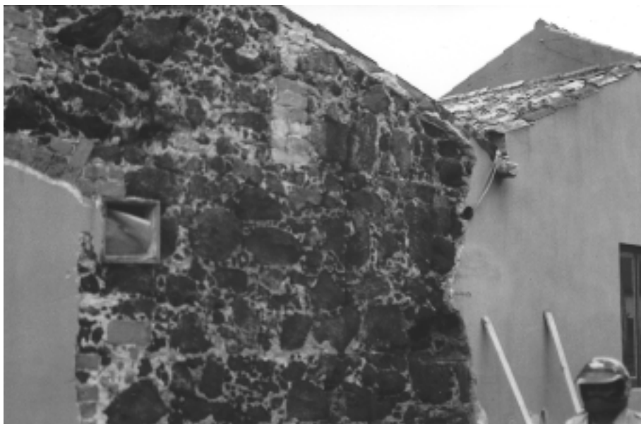
Fot. 1 - Construção antiga feita em surraipa.
