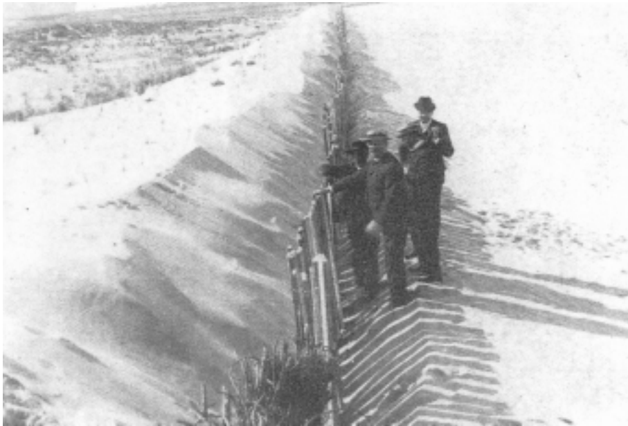
Fot. 3 - Colocação de tábuas (ripado ou paliçada) para formação de dunas (fotografia pertencente a uma colecção dos Serviços Florestais).
