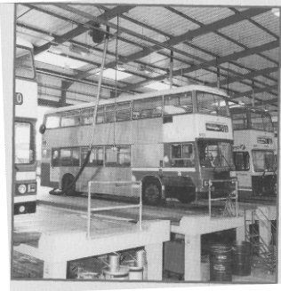
Exaustão fumos de escape
